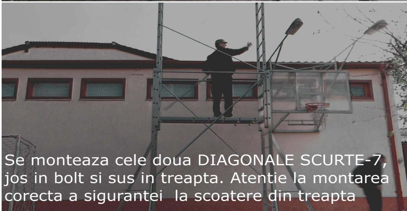
Se monteaza cele doua DIAGONALE SCURTE-7, jos in bolt si sus in treapta. Atentie la montarea corecta a sigurantei la scoatere din treapta
